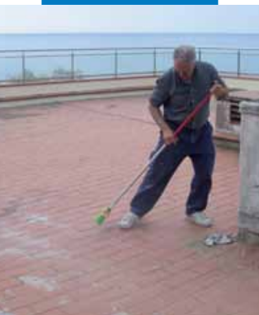
Čištění podkladu před aplikací Aquaflexu Roof
